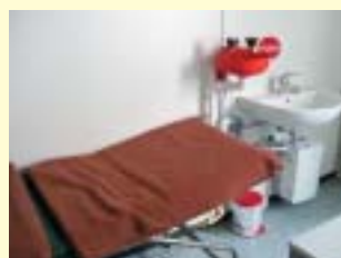
作業中の事故に備え、医務室に眼球洗浄装置を設置している
