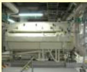
各建物に温（冷）水を送るポンプは、インバータ制御にすることで、8%の省エネにつながった。将来のコーゼネレーションにも対応できる機械を2002年7月に導入
