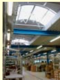
天窓から自然光を取り入れ、照明エネルギーを削減
