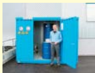
屋外に設置された規制物質保管庫
