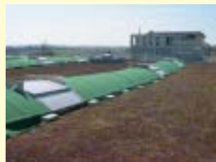
夏には緑に覆われる工場棟の屋上。日照時間の短い冬場には、防寒のため天窓にカバーをかける
