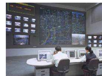
交通/道路管理システム
