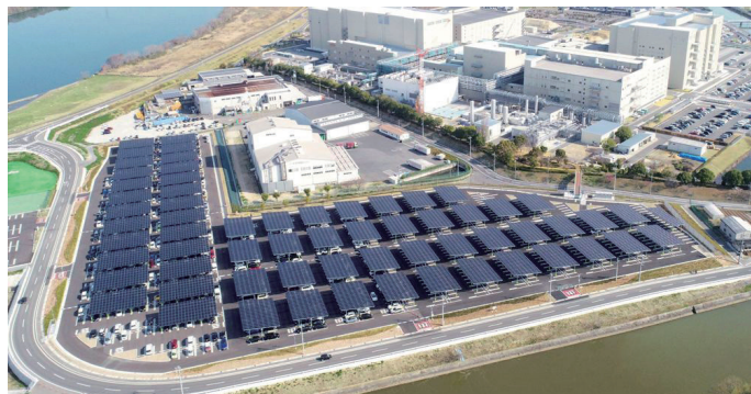
岡山村田製作所さまに設置した太陽光発電システム
