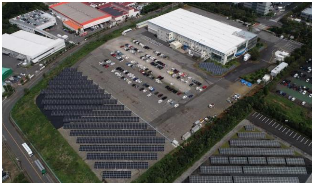
山一電機さまに導入された太陽光発電システム
