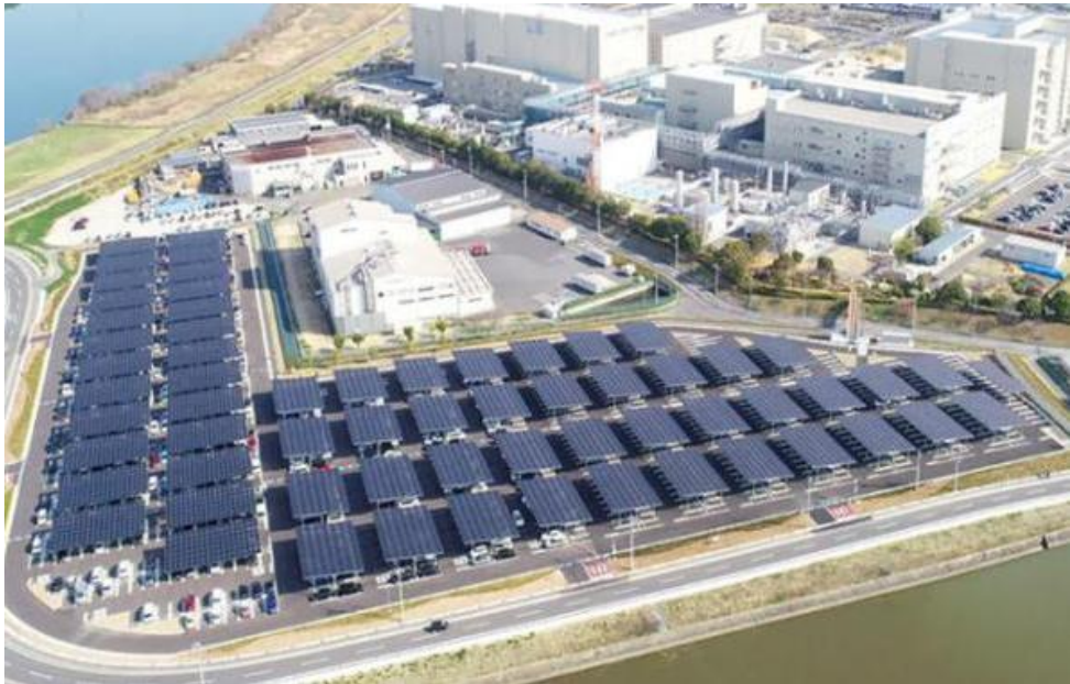
1,200台分の駐車場に導入された太陽光発電システム
