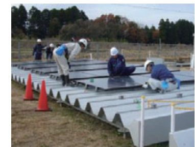
施工現地研修の様子
