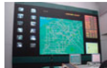
道路交通管制システム
