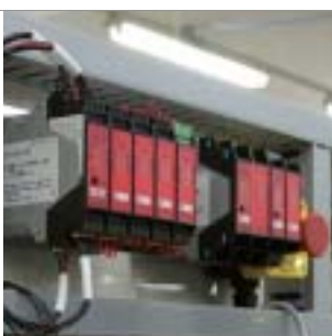
セーフティコンポーネント 機械的なガードの閉鎖検出、人の危険区域への進入確認や安全回路の構築に使用する装置
