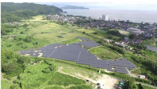
由良第一太陽光発電所
