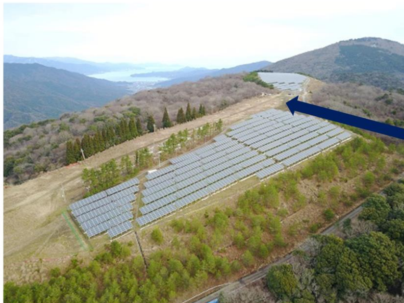
大江山第一・第二太陽光発電所
