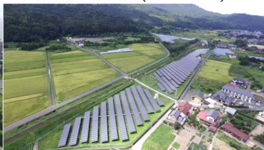
由良北太陽光発電所(第一～第三)
