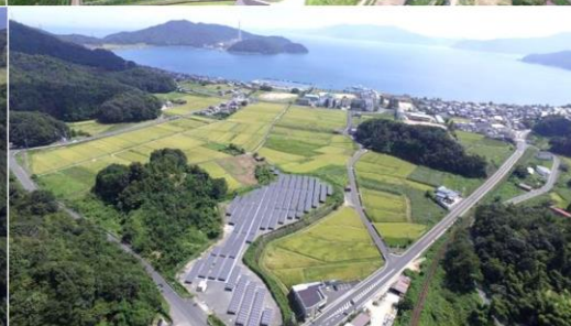
宮津市上司太陽光発電所
