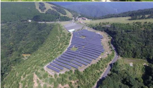
上宮津太陽光発電所
