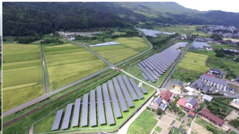
由良北太陽光発電所(第一～第三)
