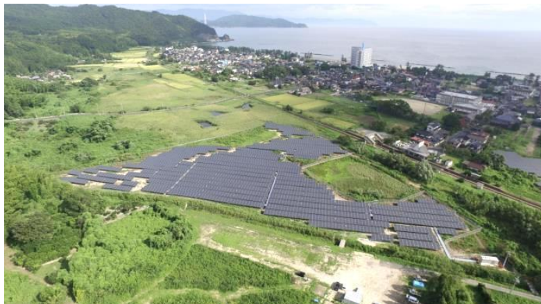
由良第一太陽光発電所
