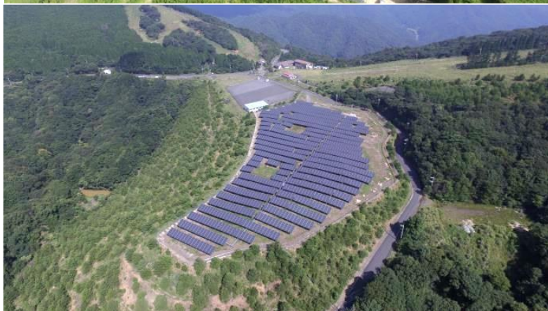
上宮津太陽光発電所
