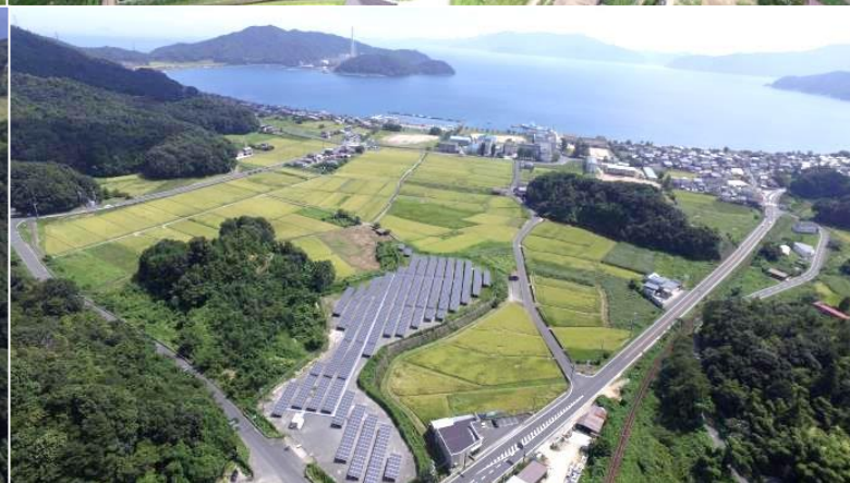
宮津市上司太陽光発電所
